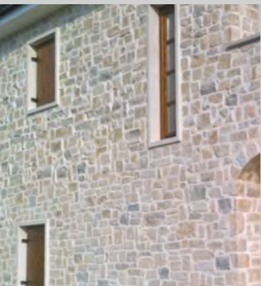
Massive Ecksteine winkelig auf 2 – 3 cm dünn ausgeschnitten Massive corner stones 2 – 3 cm thin
