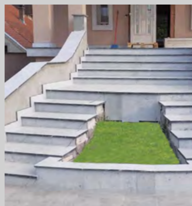
Stiegenaufgang Stair wace
