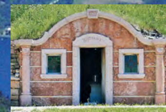
Steinumradung und Säulen Stone elements and pillars
