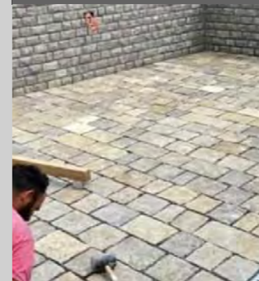
6 Pflasterplatten 20 - 40 x 20 x 5 - 7 cm Paving stones
