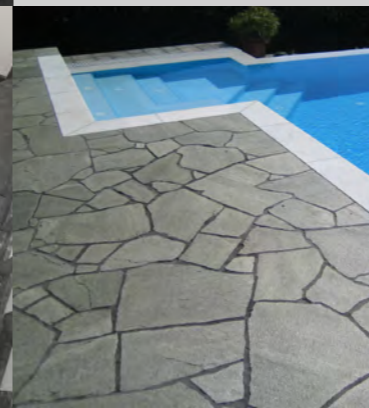
Polygonalplatten sandgestrahlt, rutschfest Polygonalplates sandblasted, non-slip
