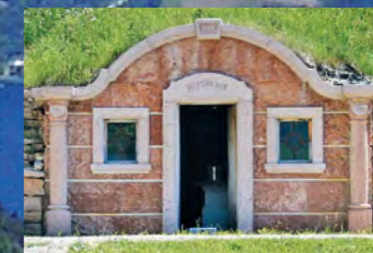
Steinumradung und Säulen Stone elements and columns
