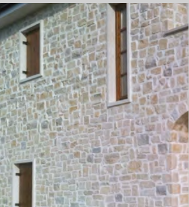
1 Massive Ecksteine winkelig auf 2 – 3 cm dünn ausgeschnitten Massive corner stones 2 – 3 cm thin
